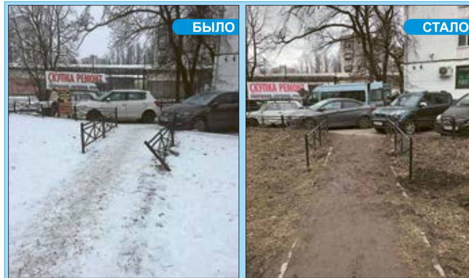
Ремонт газонных ограждений по адресу бульвар Новаторов, 79.
