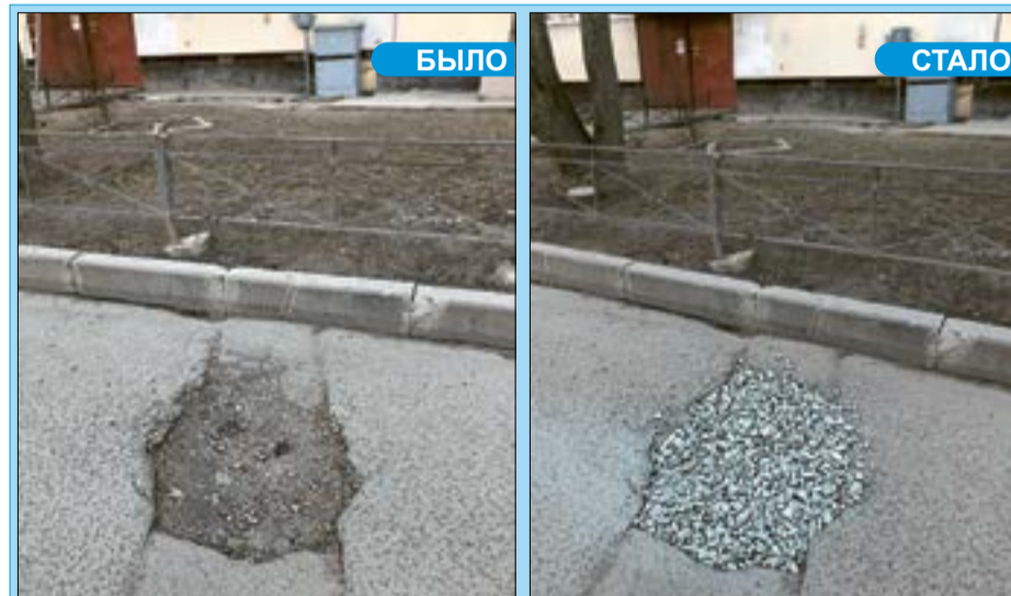
Временный ремонт асфальтобетонного покрытия по адресу пр. Ветеранов, 5, корп. 1.
