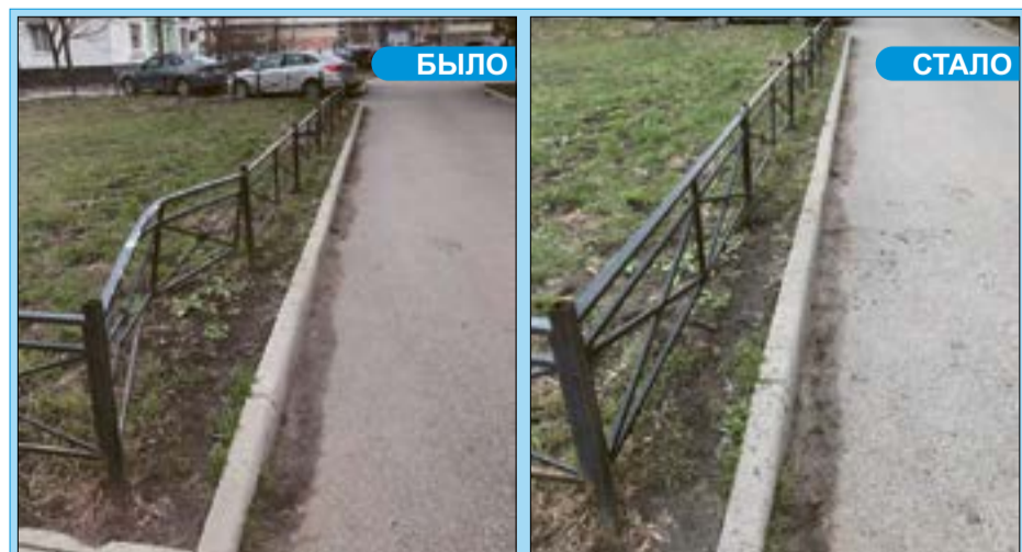
Ремонт газонного ограждения на Дачном пр., 17, корп. 2.
