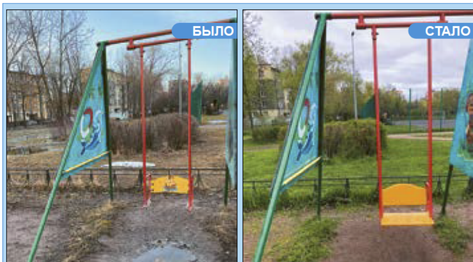
Ремонт игрового оборудования. Пр. Ветеранов, 39, корп. 2.
