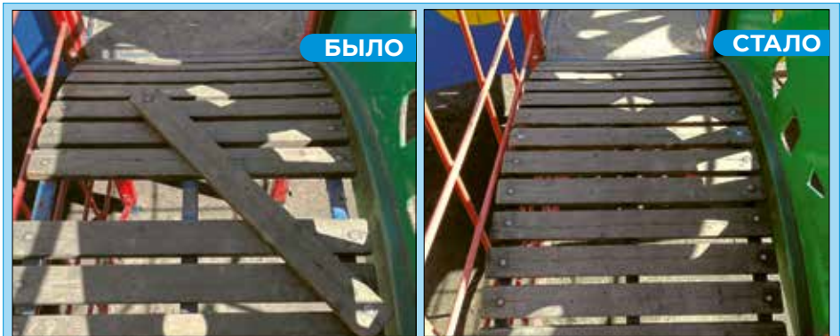
Ул. Лени Голикова, 31, корп. 5. Ремонт оборудования на детской площадке.
