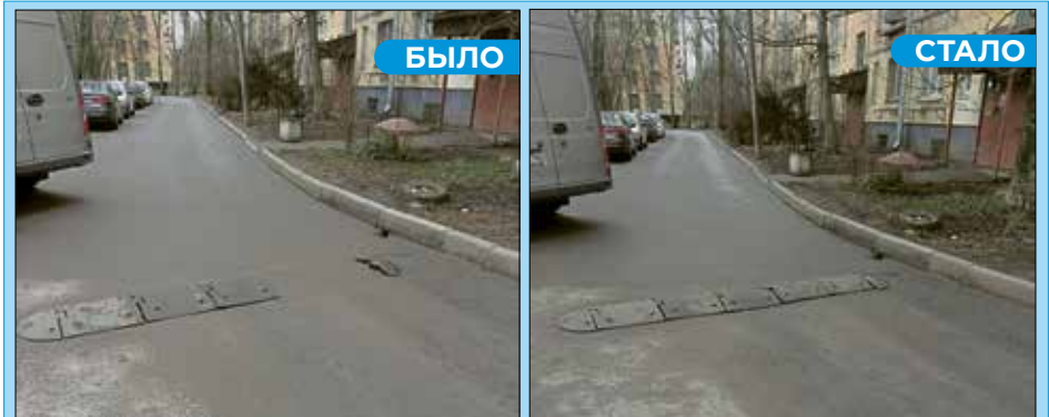
Дачный пр., 7, корп. 3. Ремонт искусственной дорожной неровности.
