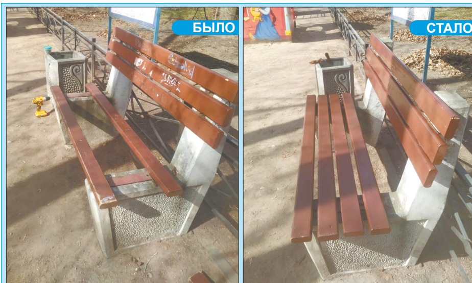
Ул. Танкиста Хрустицкого, 15. Отремонтирована скамейка на детской площадке.
