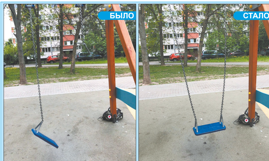
Ул. Зины Портновой, 21, корпус 1. Выполнен ремонт игрового оборудования.
