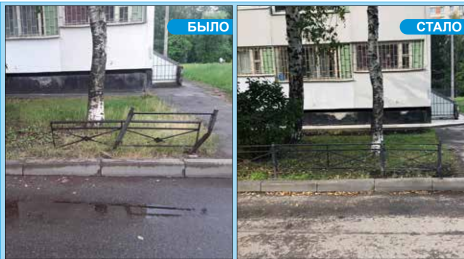
Ремонт газонного ограждения по адресу ул. Лени Голикова, 60.
