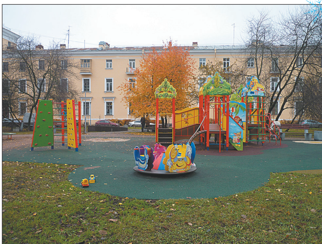
Реконструкция детской площадки возле дома №170 по пр. Стачек.
