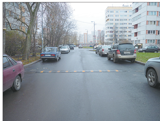
Ремонт асфальтобетонного покрытия и устройство «лежачих полицейских» у дома № 23, корп.1 по ул. Зины Портновой.
