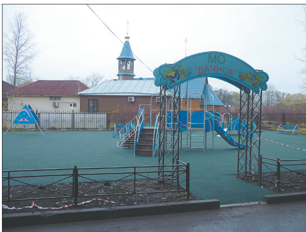
Обустройство газона и установка ограждения детского игрового городка возле дома №5 по ул. Лени Голикова.
