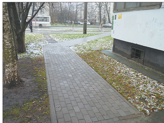
Устройство дорожки из элементов мощения (ул. Зины Портновой, 17, корп. 1).
